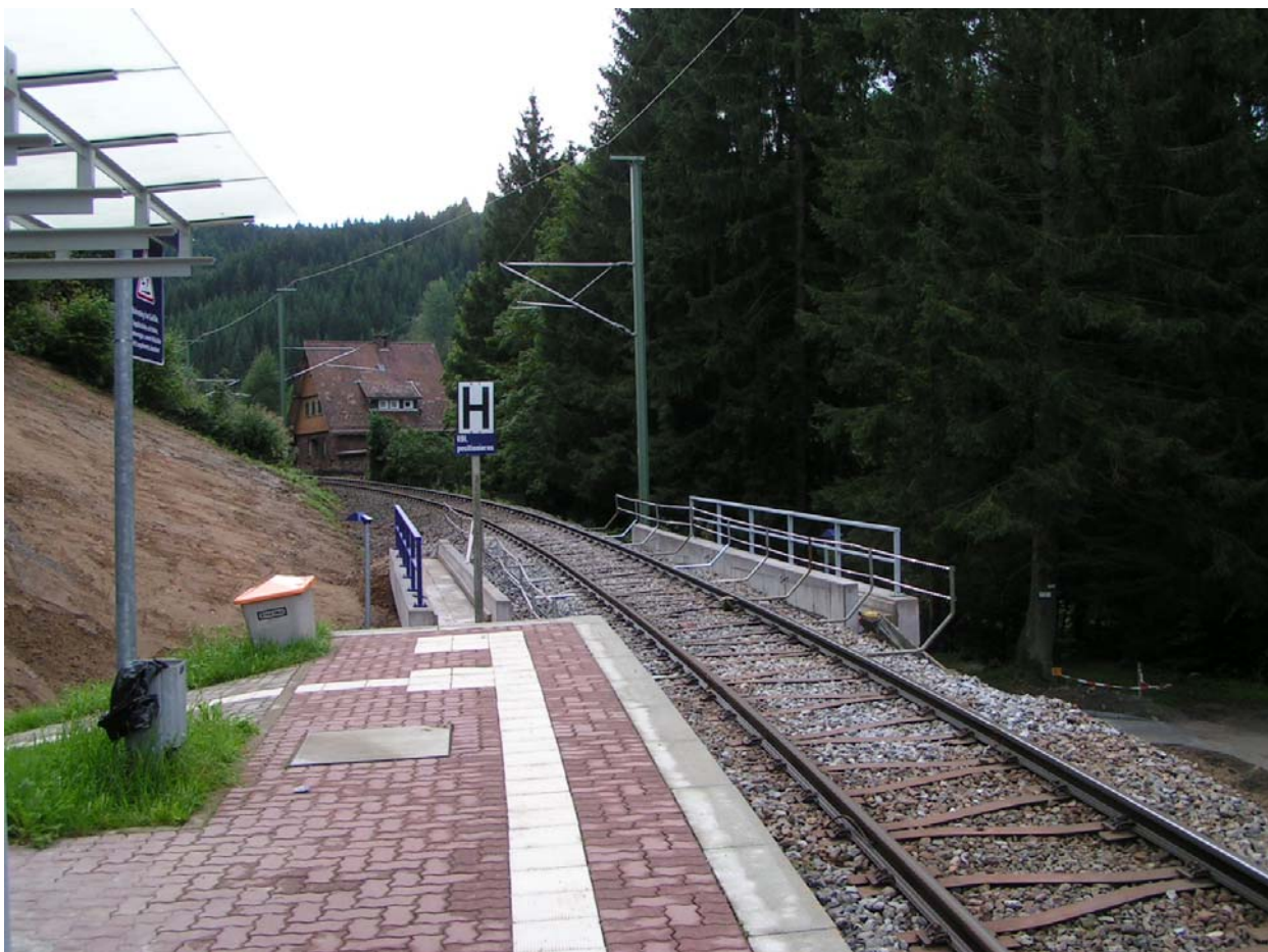
Kirchbaumwasen (der kürzeste Haltepunkt) – Gleise mit Y-Schwellen – ein Vorgeschmack auf den nächsten Bauabschnitt...
